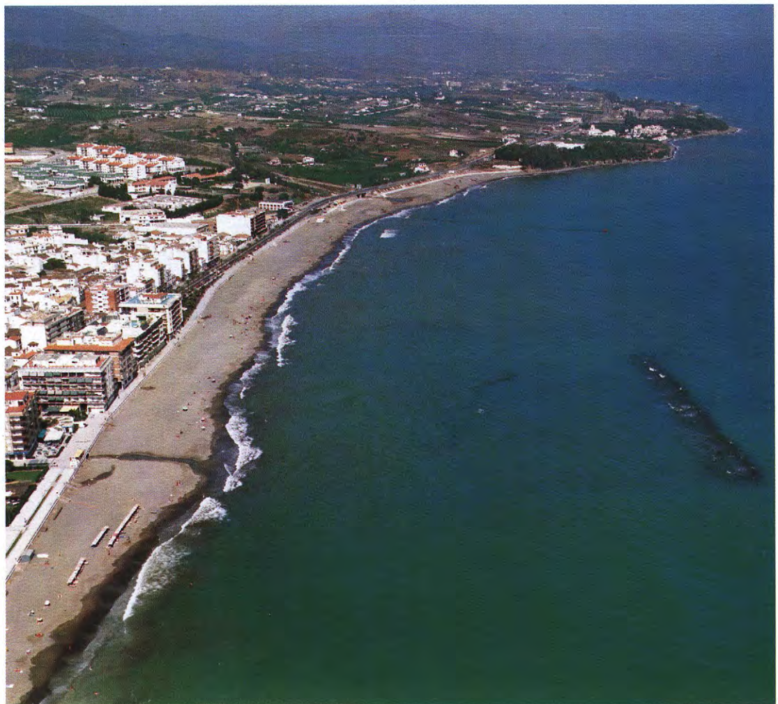
Playa de Estepona. Regeneración de la playa mediante la demolición de los cuatro espigones existentes, la aportación de arena marina y la construcción de un dique arrecife semisumergido paralelo a la playa.
