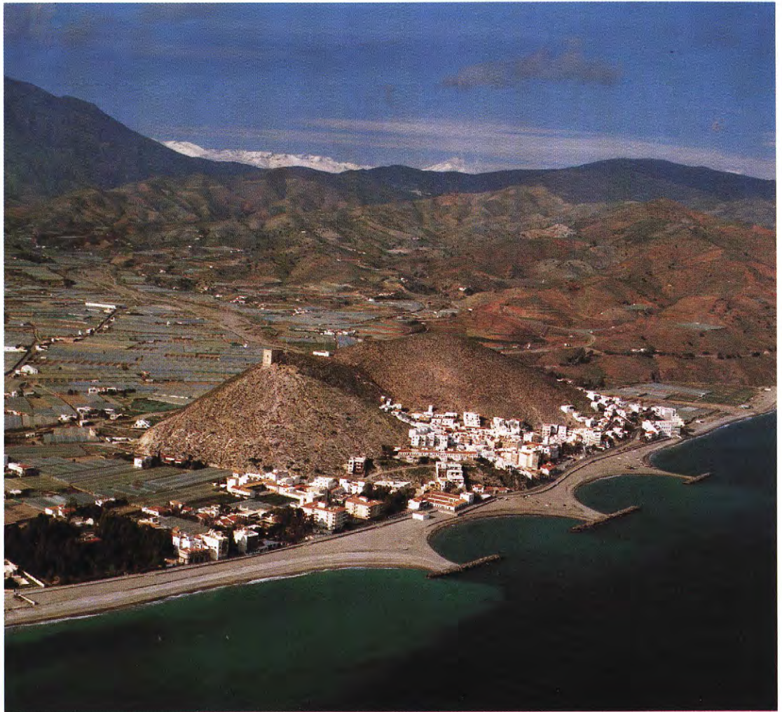
Playa de Castell de Ferro (Granada). Regeneración de la playa mediante la demolición de las ocupaciones del dominio público, la aportación de arena y la construcción de diques paralelos a la costa.
